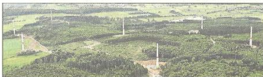
Der Windpark Hallo zur Bauzeit.
